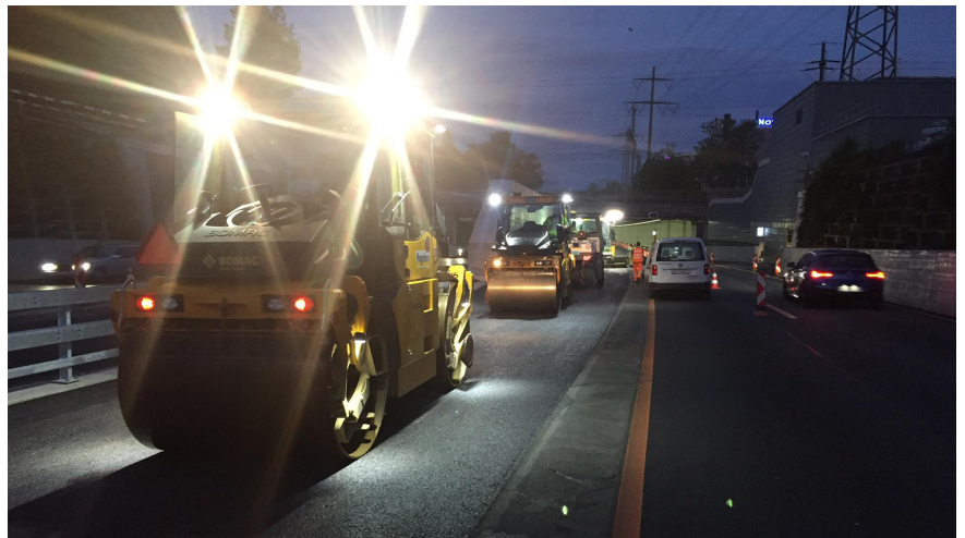
Das ASTRA führt beim Stelzentunnel bis Ende Juli teilweise lärmintensive Nachtarbeiten durch.
