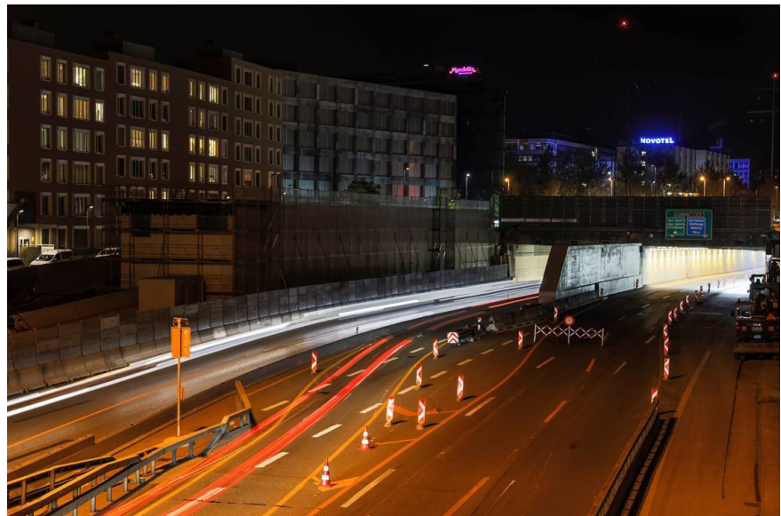
Beim Stelzentunnel sind lärmintensive Nachtarbeiten geplant.
