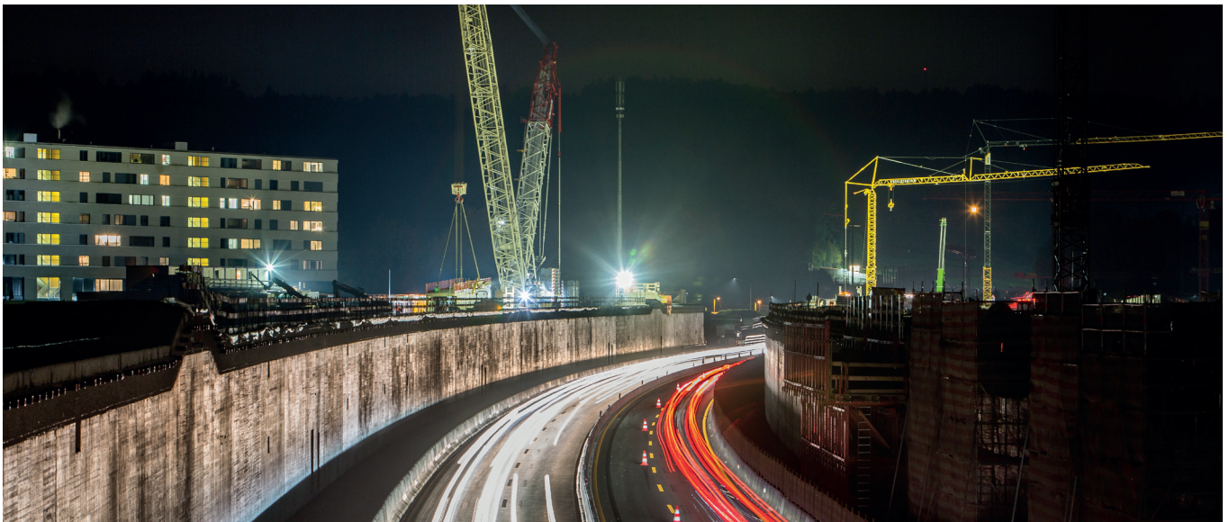
Die Nachtarbeiten bei der Überdeckung Katzenssee, Horenstein in Richtung Zürich Seebach dauern bis voraussichtlich zum 18. Juni 2018.
