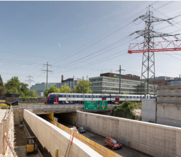
Blick auf den Stelzentunnel in Fahrtrichtung St. Gallen.
