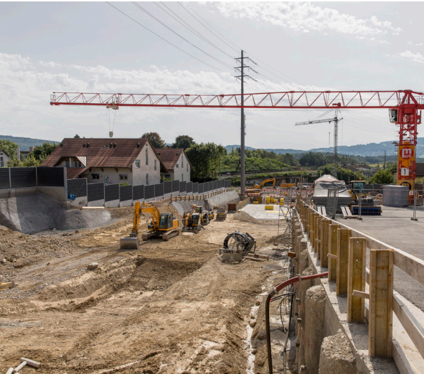
Blick in die Baugrube des Tagbaubereichs in Weiningen.
