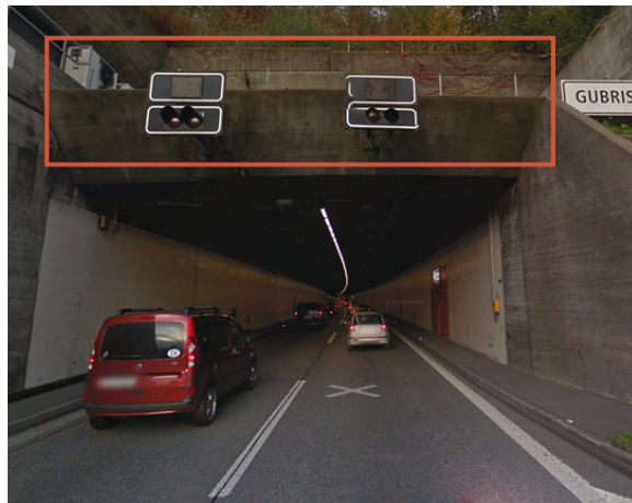
Das ASTRA baut den Pflanzentrog oberhalb der Fahrbahn der 1. Röhre Gubristtunnel in Weiningen zurück.
