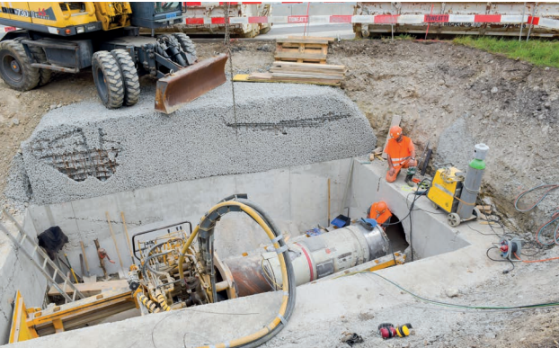
Hydraulischer Pressbohrvortrieb (Startschacht) Verzweigung Brüttisellen
