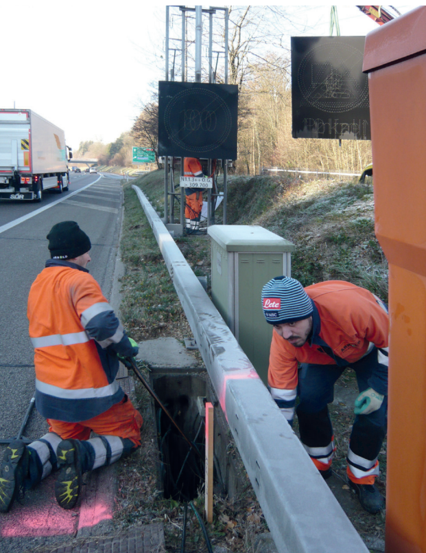
Demontagearbeiten inkl. Kabelrückzug an der Dynamischen Baustellensignalisation (DBS) im Bereich Rastplatz Baltenswil Nord.
