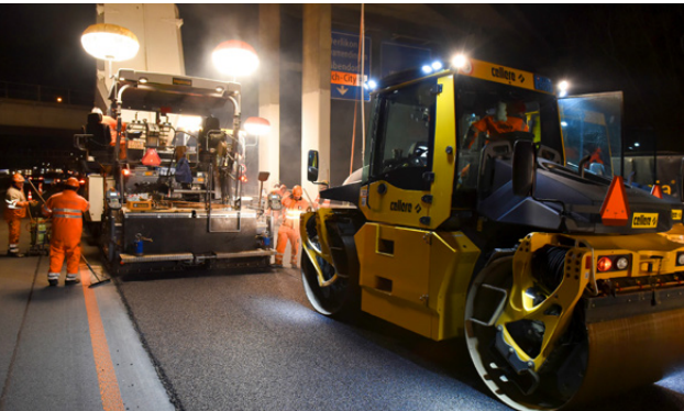
Im Bereich Verzweigung Brüttisellen stehen nächtliche Belagsarbeiten an.
