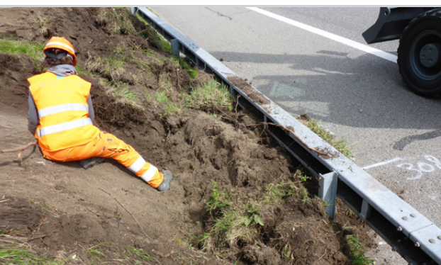
Eine Mitarbeiterin der Umweltbaubegleitung nimmt Proben in der Böschung im Bereich der Grundwasserzone.
