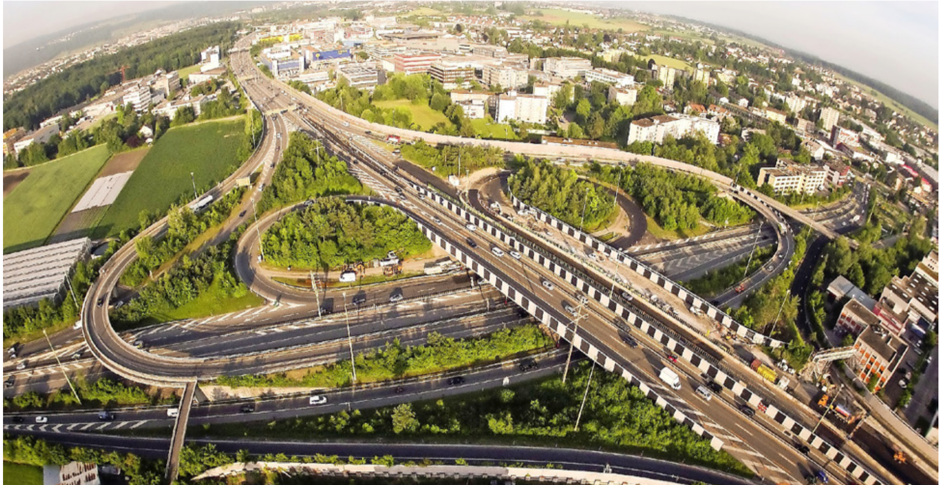
Soll mit einer umfassenden Sanierung entschärft werden: der Autobahn-Flaschenhals am Brüttiseller Kreuz. Archivfoto: Fabio Meier
