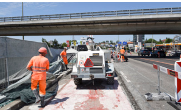
Oben: Einschwenken eines Signalportals. Unten: Instandsetzung der Überführung Neugutstrasse in Wallisellen.
