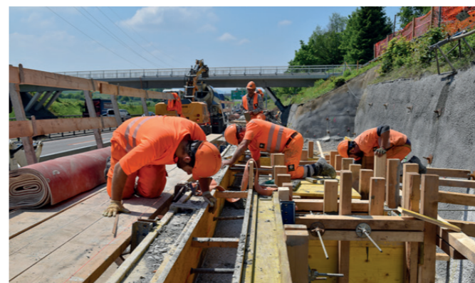
Erstellung der Leitmauer in der Nähe der Raststätte Baltenswil Nord (Mai 2018).
