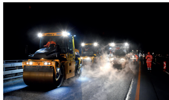
Asphaltierung der Fahrbahn im Bereich Wallisellen in Fahrtrichtung Zürich (März 2019).
