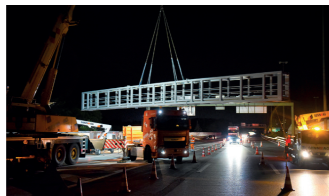
Einschwenkung der Signalportale in Fahrtrichtung St. Gallen (Juni 2019).
