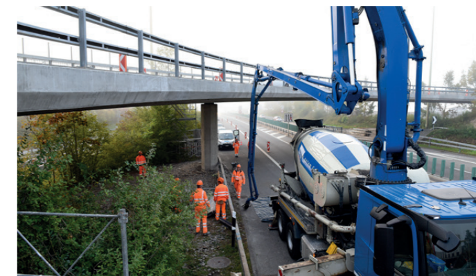
Brückeninstandsetzung bei der Verzweigung Brüttisellen (Oktober 2018).
