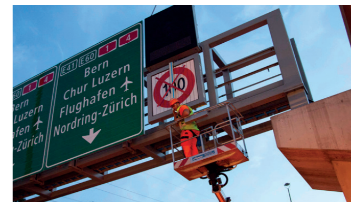
Montage von Prismenwechsel-Signalen auf Höhe Ausfahrt Wallisellen (Juli 2020).
