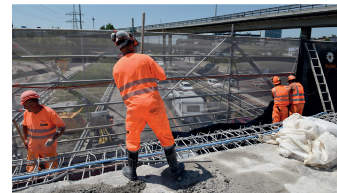
Überführung Neugutstrasse in Wallisellen: Abbruch des Konsolkopfes auf der Westseite der Brücke (Juli 2019).
