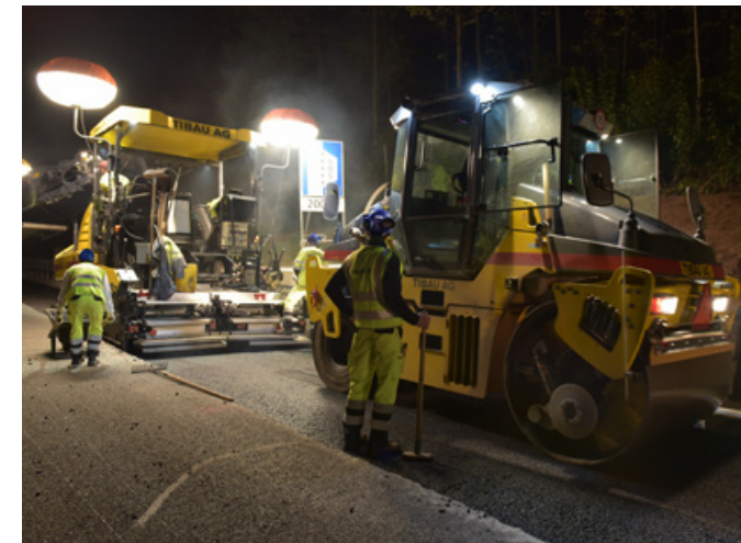
Belagsarbeiten in Fahrtrichtung Zürich, zwischen dem Anschluss Effretikon und der Verzweigung Brüttisellen, September 2017.
