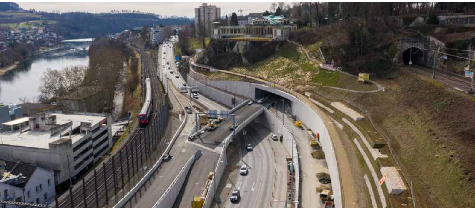
Blick auf die neu erstellte Charlottenfelsbrücke über die Schaffhauserstrasse (Bild: ASTRA Infrastrukturfiliale Winterthur)
