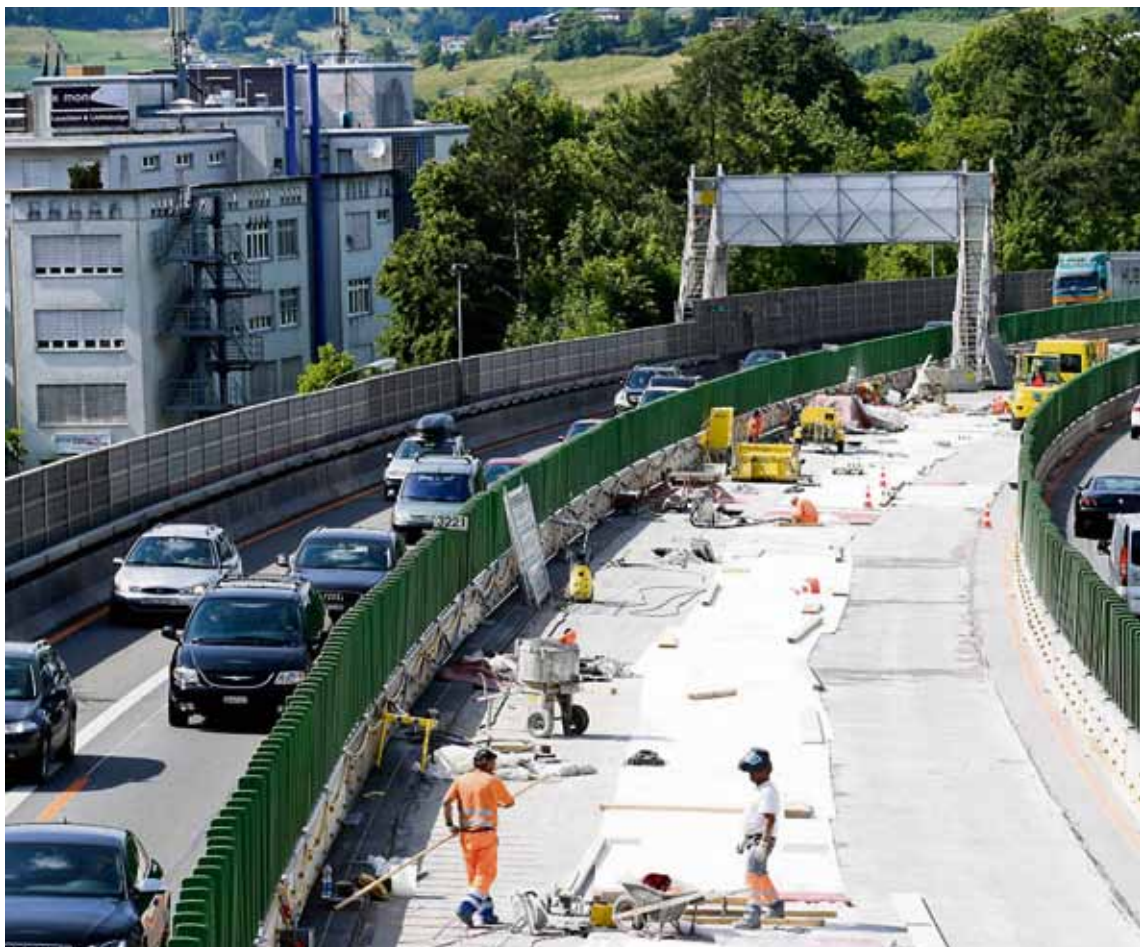
Langfristige Baustelle: Bis ins Jahr 2023 wird die A1 um Winterthur mit Pannestreifen versehen. Zusätzliche Fahrspuren genutzt werden können. Bild: © ASTRA
