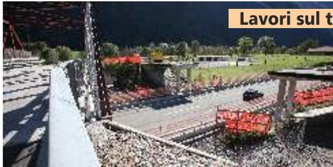
A giugno 2012 è stato varato il ponte provvisorio sulla A13 in zona Ai Mondan. Nell'ottobre 2012 sono stati demoliti i due sovrappassi esistenti La Guerscia e ai Mondan. Si è così potuto dare avvio ai lavori per l'allargamento e l'abbassamento del tracciato autostradale, che saranno ultimati nel corso del 2016.
