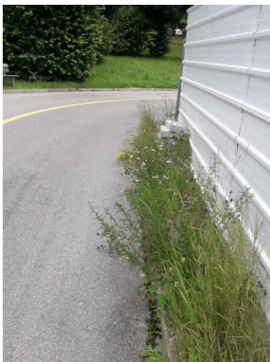
Figure 8 - Végétation perturbant les navettes Source : TPF
