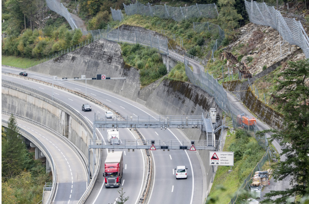
Sicherheits- und Schutznetze an der A2 zwischen Amsteg und Göschenen.
