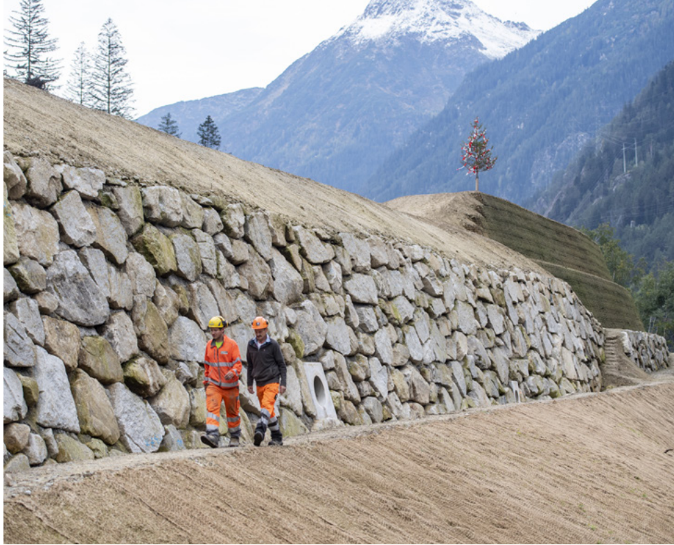
Schuttdamm an der Autobahn A2 zwischen Amsteg und Göschenen.
