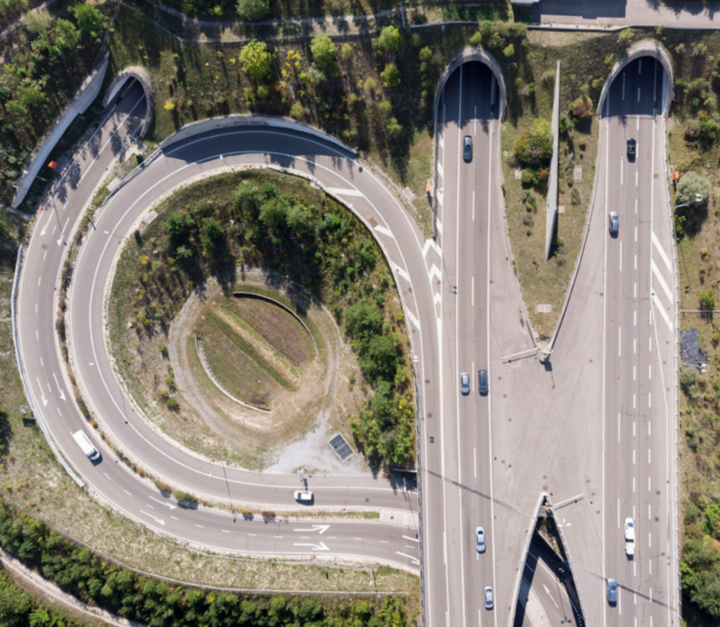
A3 und Portal des Aeschertunnels. Drohnenaufnahme bei Birmensdorf aus dem Jahr 2018.
