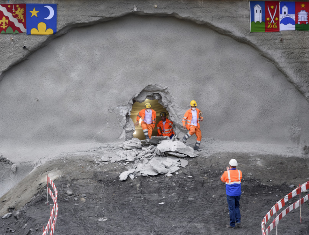
Arbeiter verlassen nach der Durchschlagung die Nordröhre des Tunnels Riedberg auf der Baustelle der A9 bei Gampel.
