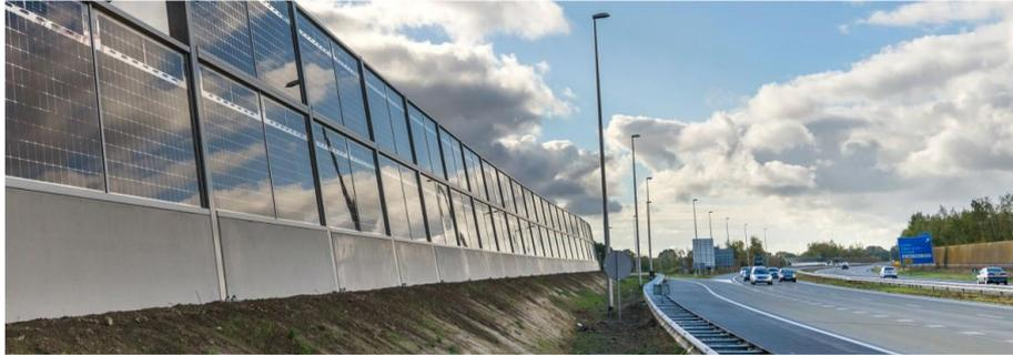
Abbildung 10: LSW mit bifazialen Solarmodulen entlang der A50 in Uden, Niederlande, im Rahmen des Projekts Solar Highways [10]
