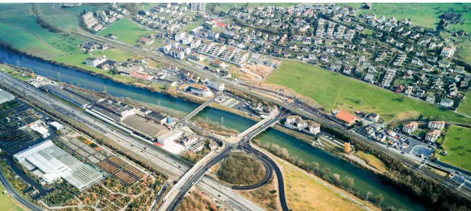
Im Bereich des Anschlusses Gisikon Root wird lärmschluckender Porenasphalt verbaut.
