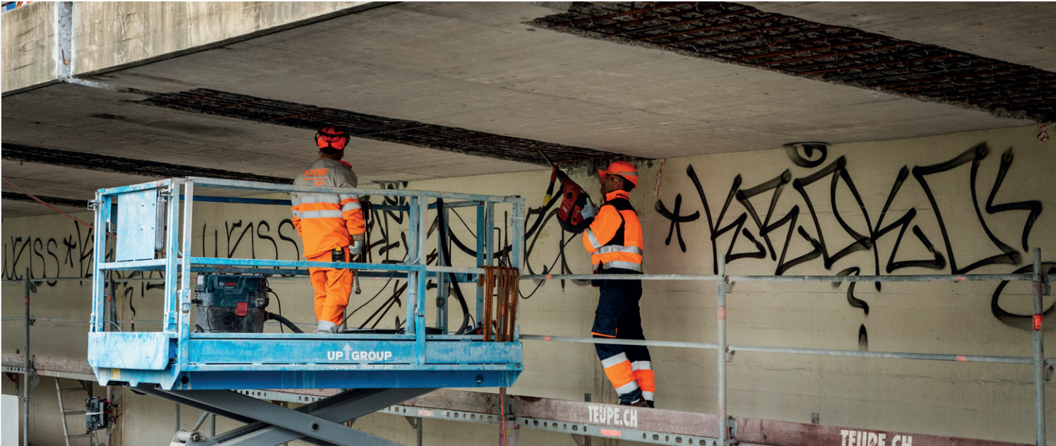
Die Strassen von Bund und Kanton greifen an vielen Orten ineinander, das bedingt eine enge Zusammenarbeit in der Planungs- sowie der Ausführungsphase
