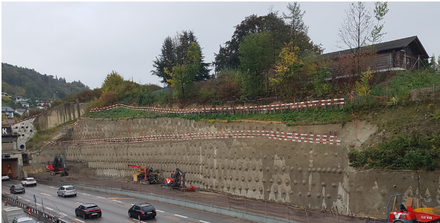
Bagger heben die Baugrube beim Chriesihoger aus.
