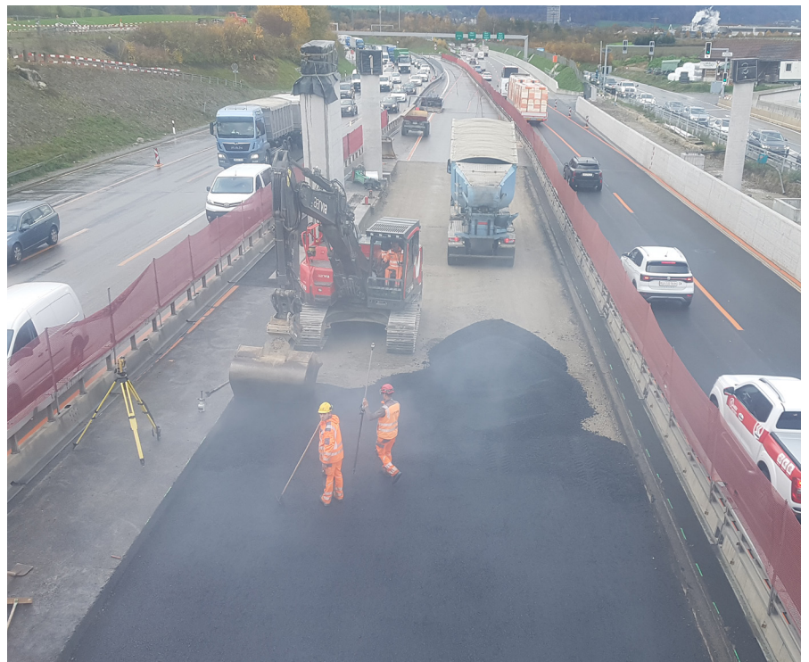
Belagseinbau auf der Mittelspur in Weiningen.
