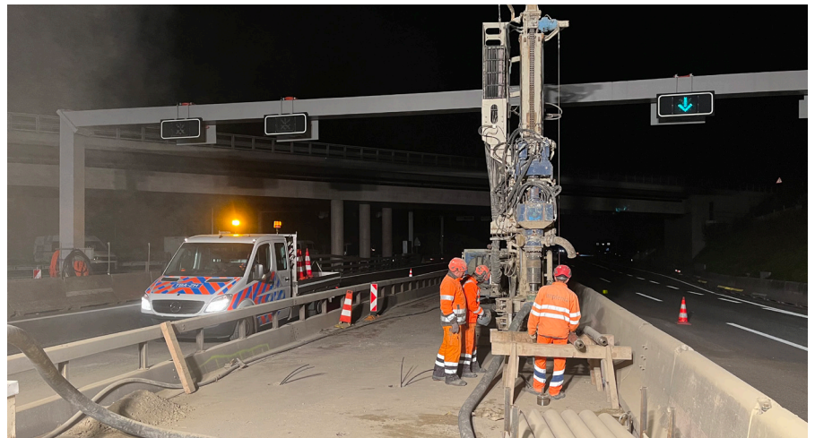
Der Bau der Logistikbrücke startete im Oktober mit den Mikropfahlarbeiten.
