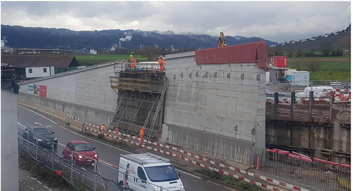
Bei der Überführung Klosterweg wurde die Widerlagerwand Nord betoniert.
