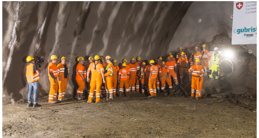
Der Durchstich am 22. September 2020 markierte ein wichtiges Etappenziel.
