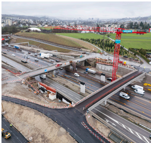
Die neue Überführung Klosterweg im Vordergrund ersetzt die alte Überführung im Hintergrund.
