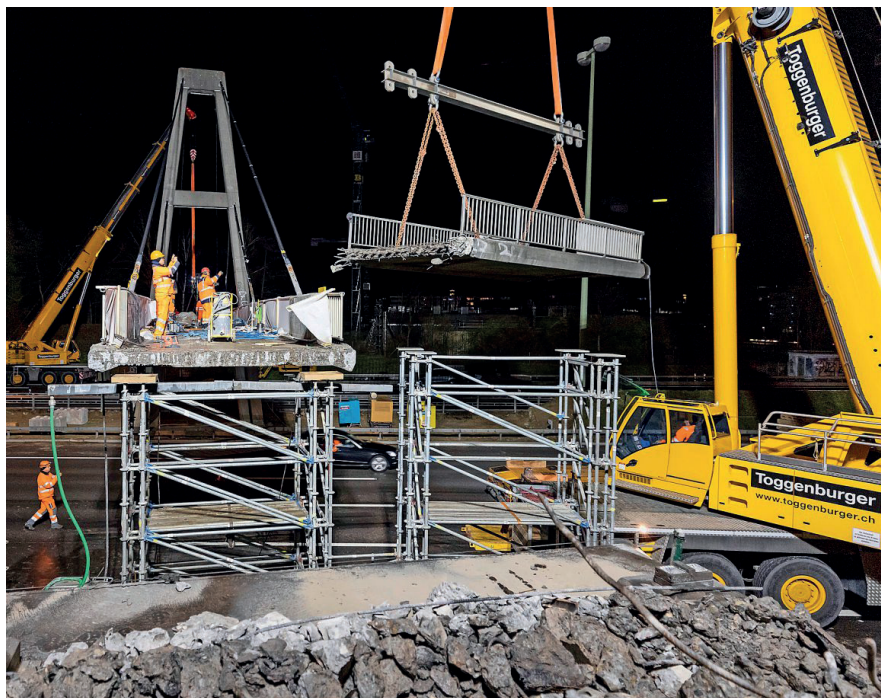
Die Überführung Oberwies bei Wallisellen wird abgebrochen und stückweise abtransportiert. Foto: Christian Merz
