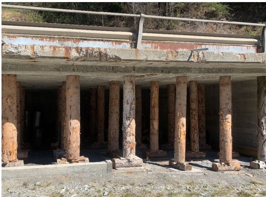
Ponte Garin, fra Liddes e Bourg-St. Pierre: puntellamento provvisorio di sostegno.
