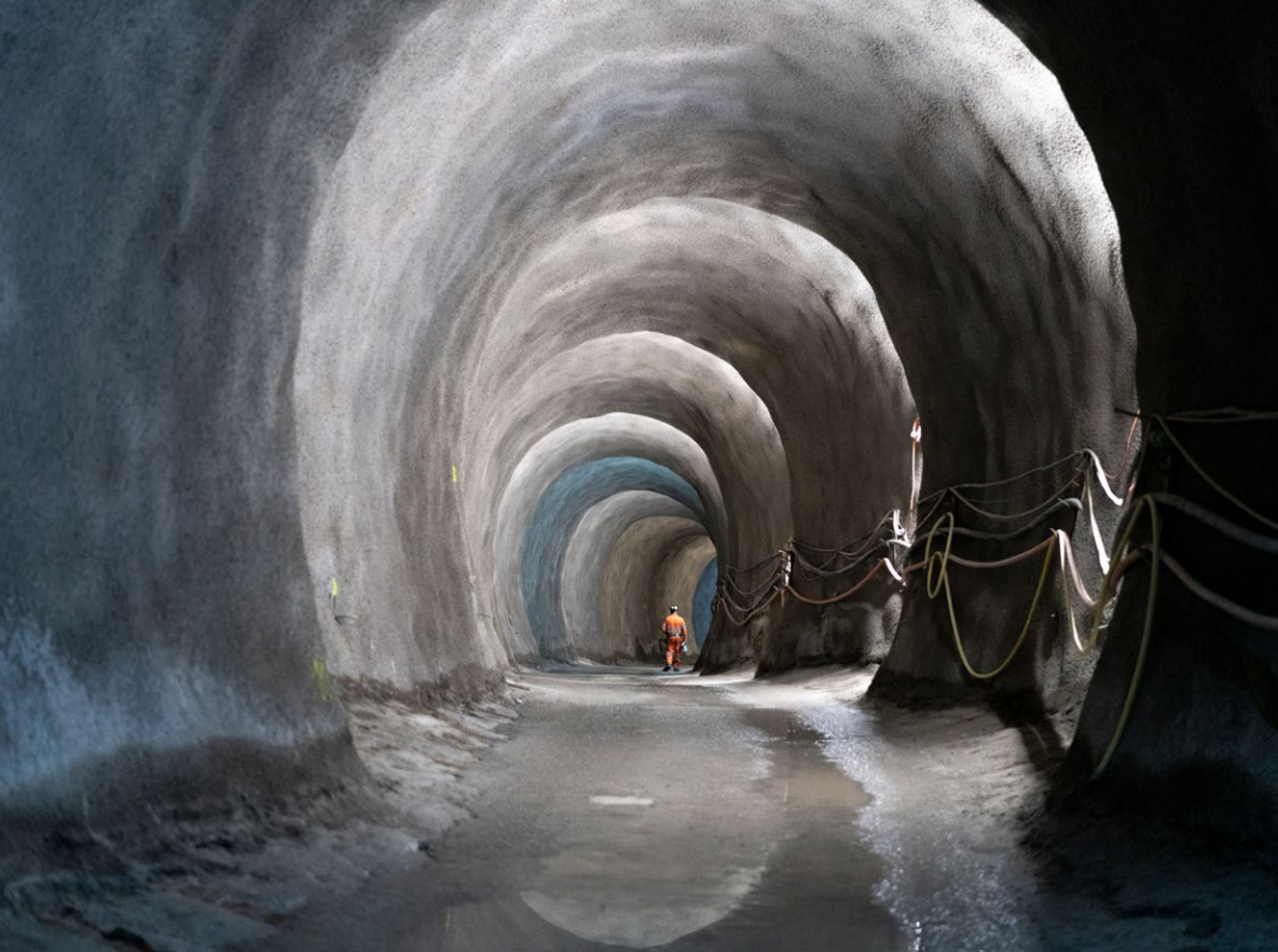
Minatori all'opera nel cunicolo di sicurezza della seconda canna della galleria autostradale del San Gottardo.
