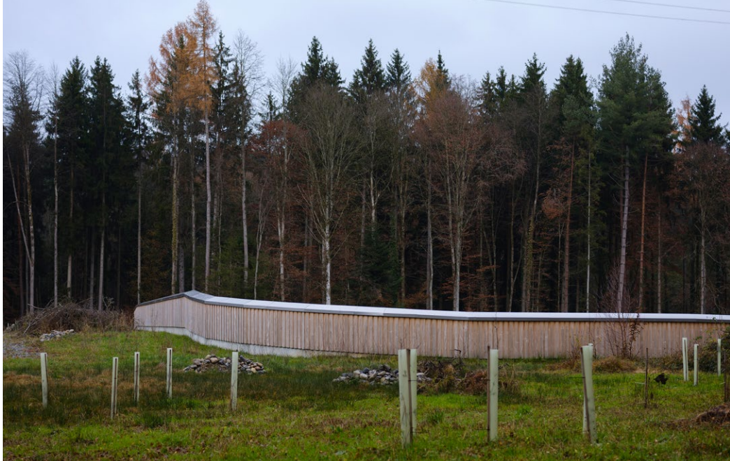
Passage à faune en bois sur l'A1 dans la région de Rynetel entre Suhr et Gränichen.
