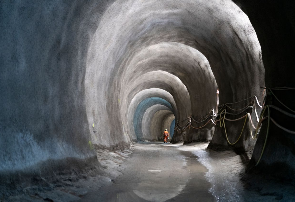
Des mineurs travaillent dans la galerie de sécurité du deuxième tube du tunnel routier du Gothard.
