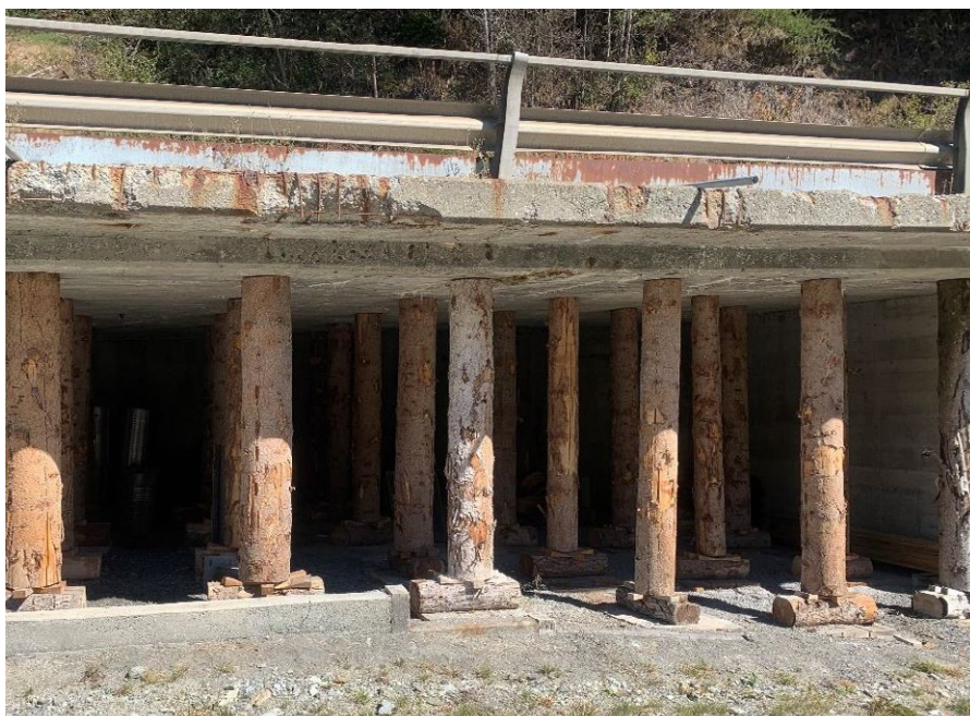
Pont Garin entre Liddes et Bourg-St. Pierre, support provisoire sous l'ouvrage.
