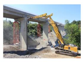
Démolition d'une tête de pile en forme de marteau au moyen d'une pelle mécanique de 190 t
