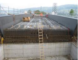
Section transversale en auge avec goujons Dalles préfabriquées en béton armé utilisées comme coffrage
