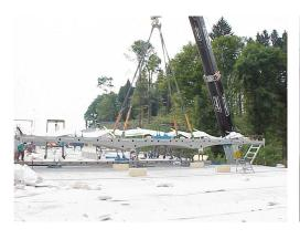
Montage de la dalle de roulement avec une grue mobile
