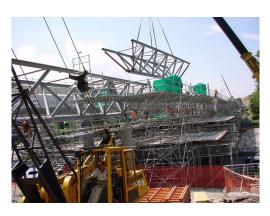
Montage du treillis métallique avec une grue mobile
