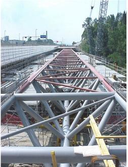
Section transversale avec contreventement Goujons connecteurs au niveau de la culée
