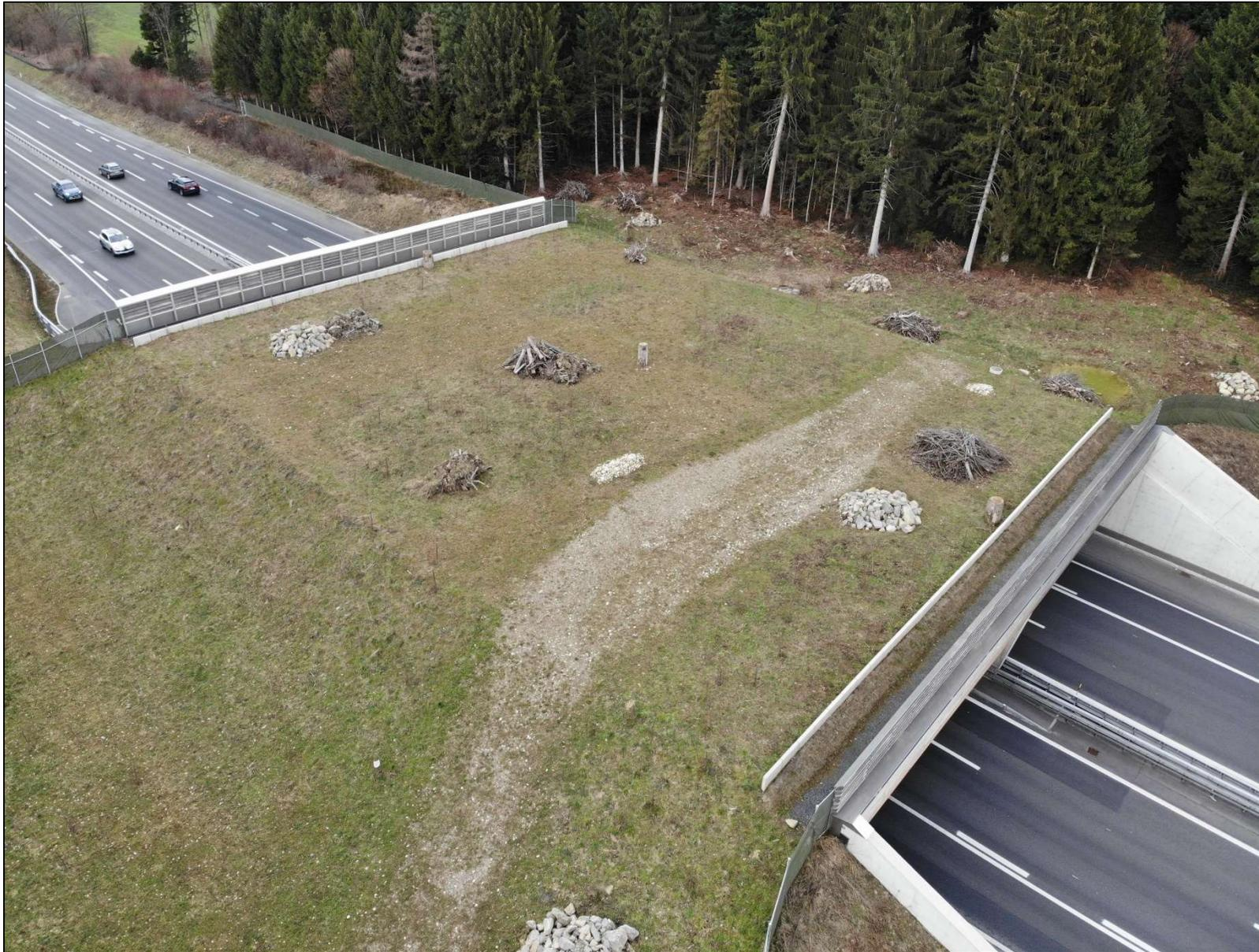
**Abbildung 4: Fertiggestellte Wildtierüberführung gemäss dem Situationsplan (Abbildung 3) mit zahlreichen Strukturen wie Ast- und Steinhaufen, Trockenstreifen oder auch bepflanzte Wildhecken. Die aufrechtplatzieren Eichenstämme (total 3 Stück) tragen ebenfalls zur Strukturierung bei und konnten gleichzeitig für die Befestigung der Fotofallen verwendet werden. Quelle: DS Iawa, März 2023**
